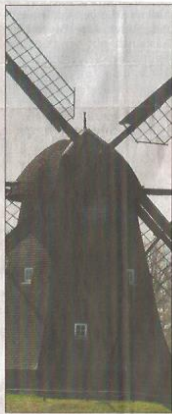
Restaurierungsbedürftig: die rund 250 Jahre alte Schutenmühle in Löningen-Huckelriede.
